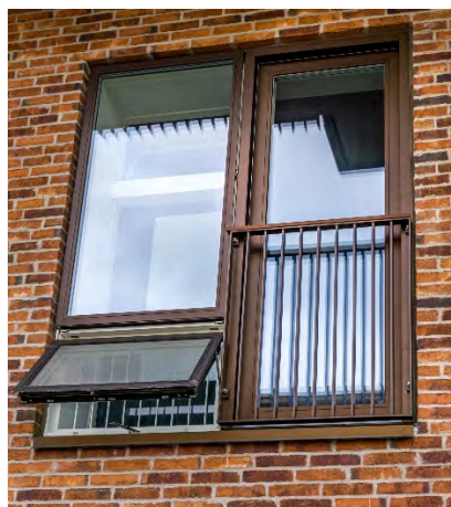
Figur 22. Støjdæmpende multifunktionsvindue (billederne til venstre og i midten). Støjen dæmpes på vejen gennem åbningen for neden (udendørs) til åbningen for oven (indendørs). Til højre er vist en lydskodde, som er monteret foran et eksisterende vindue. Den dæmper støjen, men giver også adgang for frisk luft. Den kan desuden mørkelægge et rum, hvis det ønskes.
