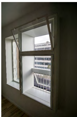
Figur 22. Støjdæmpende multifunktionsvindue (billederne til venstre og i midten). Støjen dæmpes på vejen gennem åbningen for neden (udendørs) til åbningen for oven (indendørs). Til højre er vist en lydskodde, som er monteret foran et eksisterende vindue. Den dæmper støjen, men giver også adgang for frisk luft. Den kan desuden mørkelægge et rum, hvis det ønskes.
