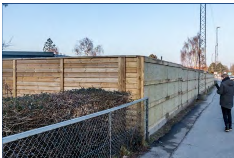
Figur 26. Her har grundejeren bygget sit eget støjhegn og brugt mineraluld på siden mod vejen. Hegnet har formentlig en god støjdæmpende virkning fordi det er tæt, har en god højde og går op i skel vinkelret på vejen. Mineralulden har ingen betydning for hegnets støjdæmpende virkning hos grundejeren.
