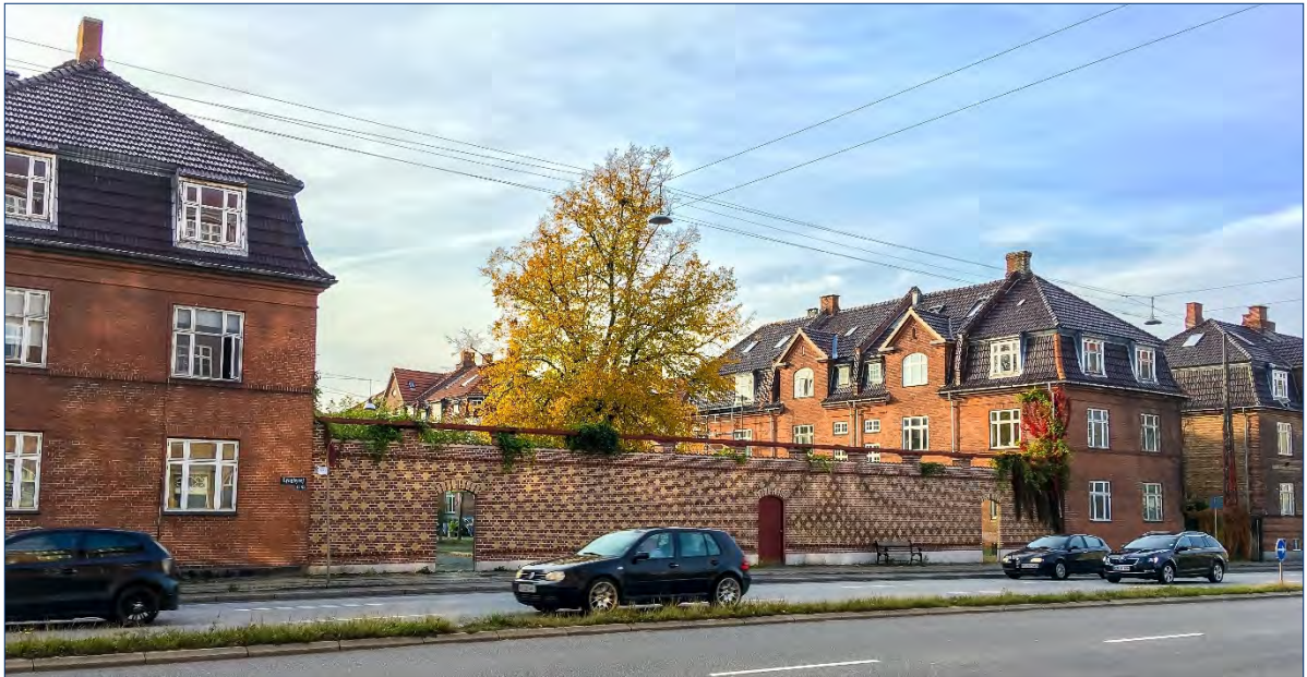
Figur 28. Her har en grundejerforening bygget en støjskærm i åbningen mellem to husrækker. Resultatet er et støjbeskyttet område bag skærmen (Lyngbyvej, København)
