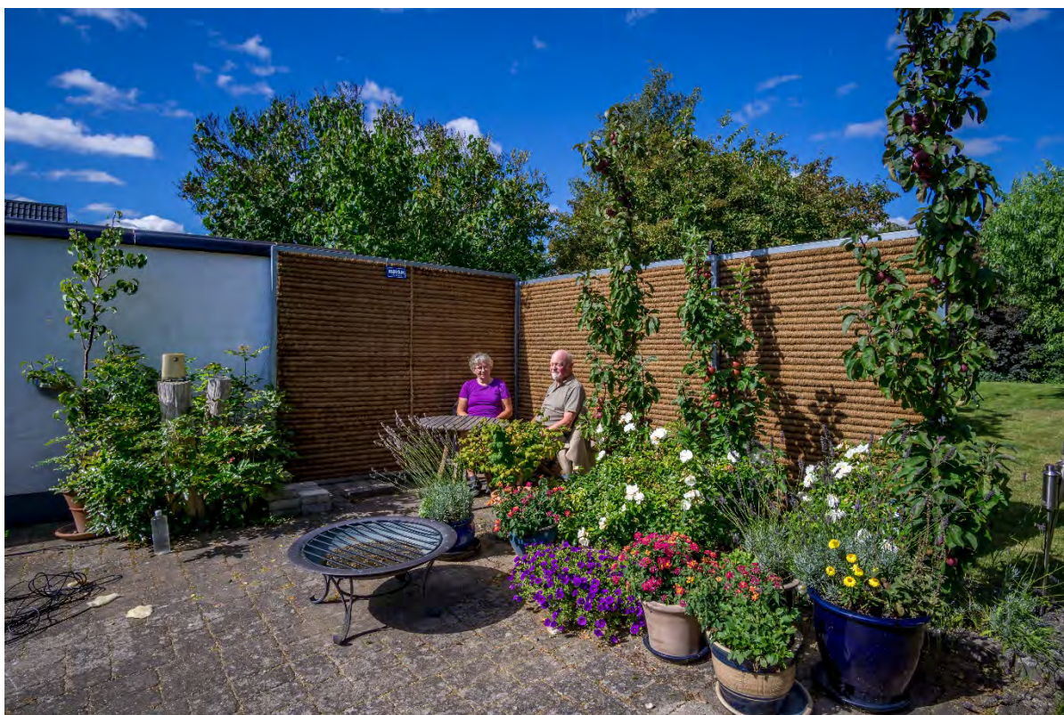
Figur 25. Et støjhegn kan skabe en støjfærmet krog eller terrasse. Den støjdæmpende virkning kan opleves i et mindre område lige op af hegnet (fra en forsøgssopstilling i en have i Glostrup).
