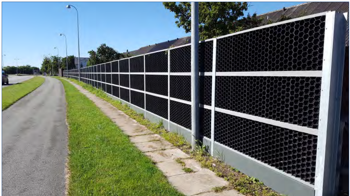
Figur 15. Eksempel på støjskærm langs et boligområde. De sorte akustiske elementer i skærmen består af materiale fra genbrugte vindmøllevinger (Vallensbæk).
